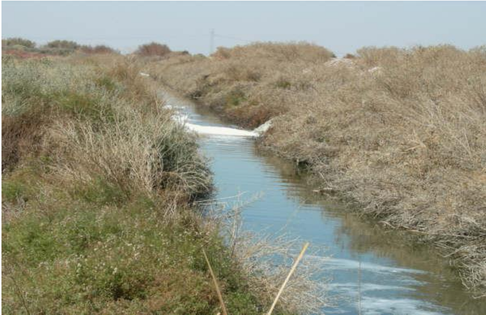
CANAL DE FUGA – SALIDAS DE LAS LAGUNAS
