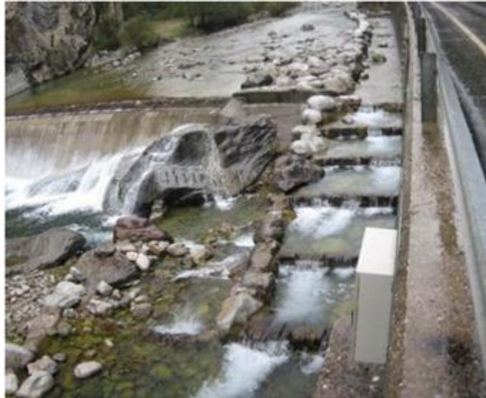
*Figura 3. Escala de peces en la toma de la Central de Salinas, en el río Cinca (Huesca). Este paso se corresponde con una escala de artesas sucesivas en vertido libre. Se trata de un paso funcional para salmónidos.*
