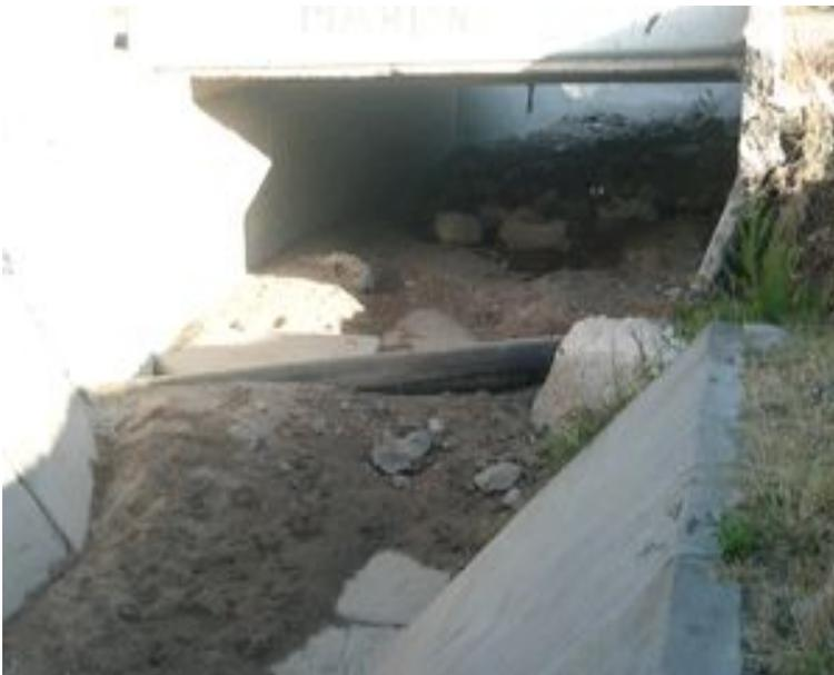
Foto N° 13. Caños de Agua Potable Atravesando Canales Principales. (Merlo y Ortiz, 2012).
