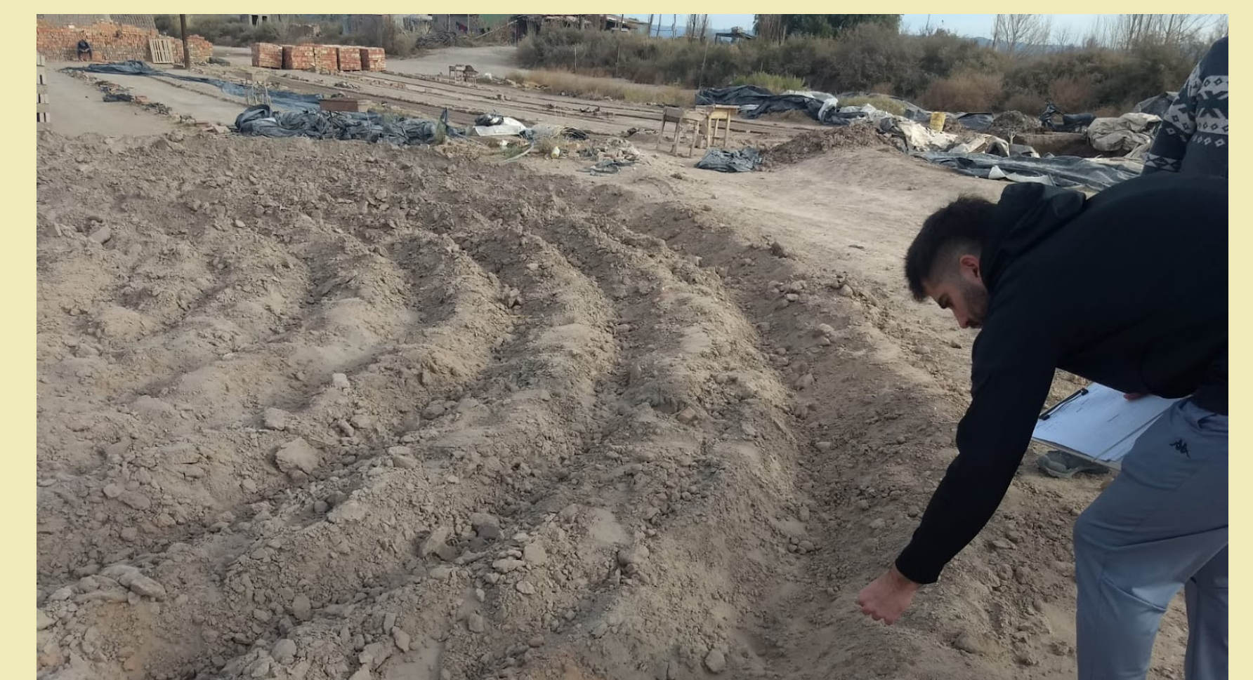
Figura 4 - Alteraciones superficiales de rueda dentada en pisadero.
