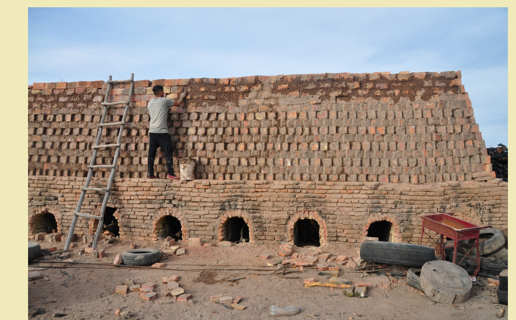
Figura 7 - Trabajador impermeabilizando pared de horno con rafa.
