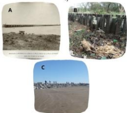
Fig. 3: A) construcción del tablestacado portuario en 1885 (Archivo Bradley); B) Construcción de camino a la playa sobre el tablestacado (Fuente: https://salvemoselmontedeberisso.blogspot.com/ ); C: escollera sudeste.
