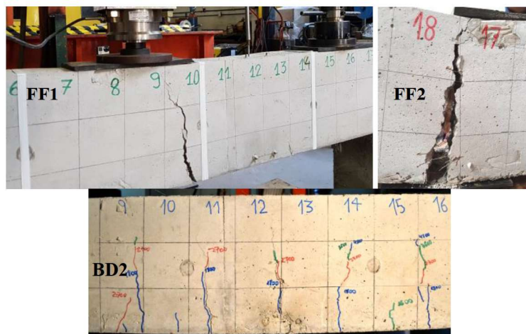
Figura 5. Detalles de fisuras en las vigas FF1, FF2 y BD2.
