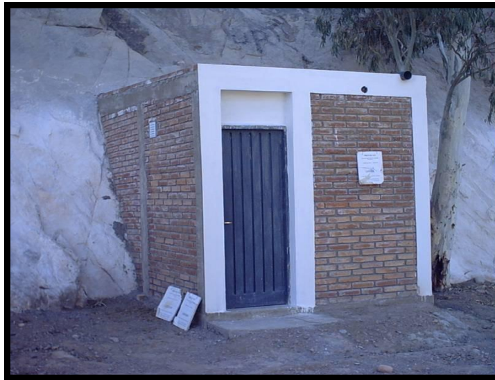
Figura 4. Estación de EA en el Cerro Blanco, provincia de San Juan.
