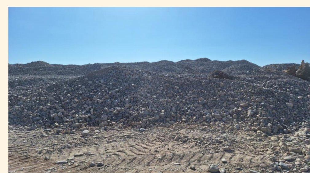
Imagen 5. Frente de extracción de material
