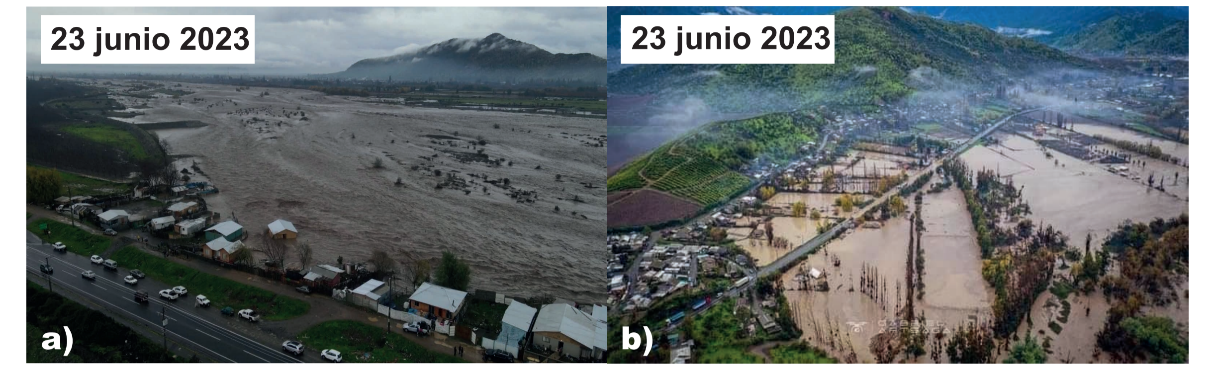
Fig. 4: a) Destrucción de viviendas por erosión regresiva de la terraza aluvial en Doñihue (TVN Red O'Higgins). b) Inundación del sector Cerrillos (Doñihue) vista desde el aire (hacia el noreste). Diario el Pulso.
