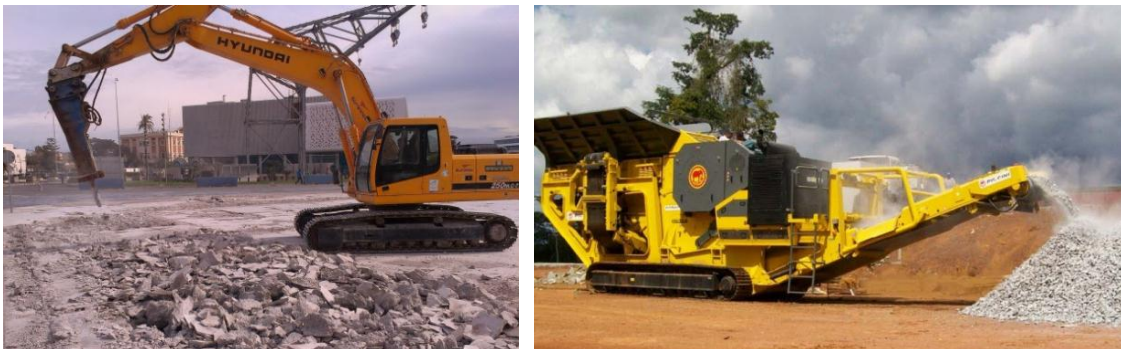
Figura 1: Demolición de losa y trituración del hormigón para transformarlo en agregados reciclados.
