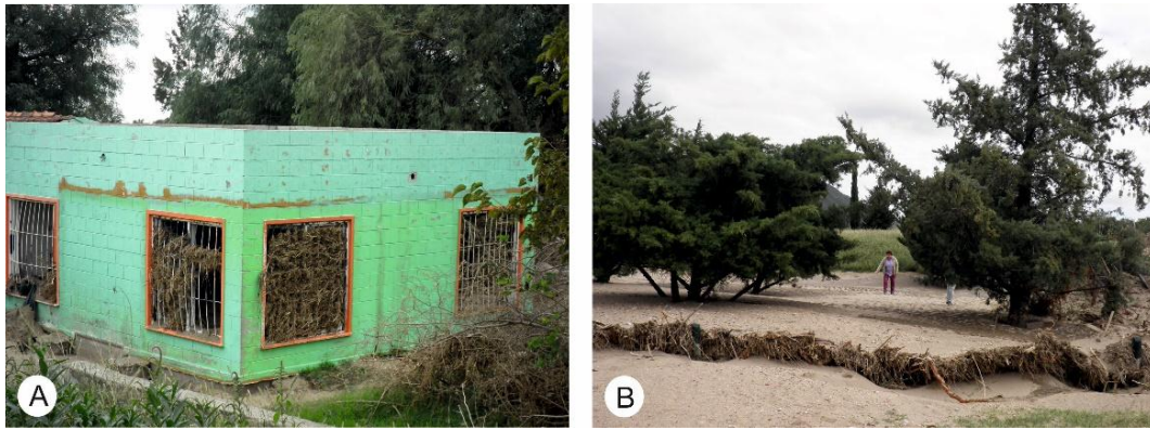
Fig. 4: Evidencia de la inundación de marzo del 2015. A. Obsérvese la marca en la pared de la altura alcanzada por el agua; la foto corresponde a viviendas ubicadas a menos de 100 m de la margen del actual cauce del río Luján. B. Esta foto fue tomada en la confluencia del A° Las Higuieritas con el río Luján; obsérvese como los sedimentos llegan a la base de la copa de los pinos y como han sepultado un alambrado.
