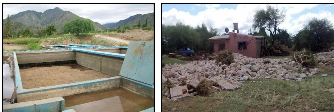
a. Figura 2. a. Piletas de agua potable cubiertas de sedimentos. b. casa afectada por creciente del río Lujan
