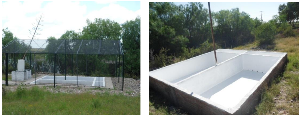
Figura 1. Vista interna y externa del MDV. a. Vista de las piletas y su conexión a cámaras colectoras. b. Vista del Laboratorio
